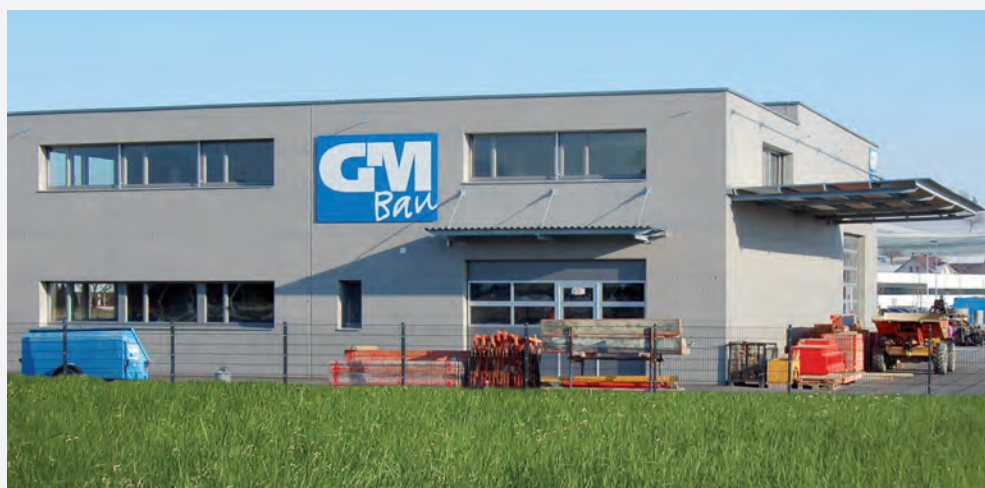
Le nouvel atelier de la société : une construction maison de qualité en béton apparent.
