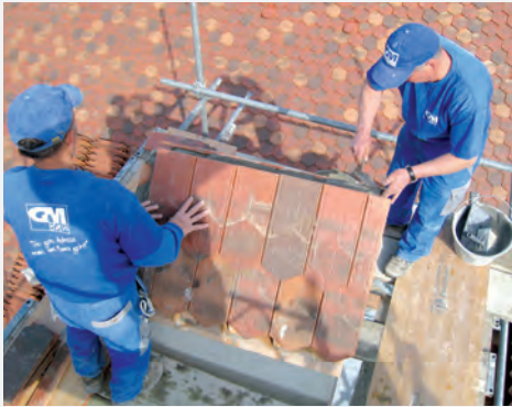
Réfection d'une cape de cheminée.
