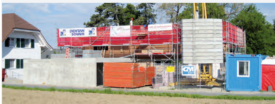
Die blauen Baucontainer (rechts), aber auch Schalungsmaterial (Mitte) oder Bautoiletten (rechts aussen) transportiert Haldimann AG.
