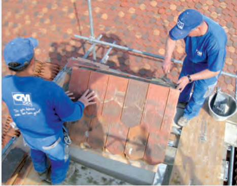
Ein „Berner Hut“ wird erneuert.
